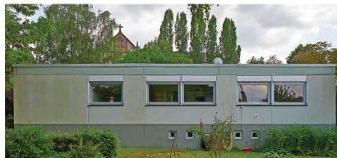
Mit ihrem Plattenbausystem eroberte die Forbacher Baufirma Camus-Dietsch in den 60ern auch den saarländischen Markt.
